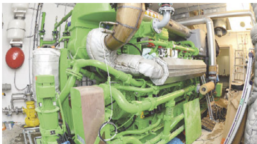
Das Blockheizkraftwerk an der derzeit im Bau befindlichen Biogasanlage der Agrar GmbH Geißmannsdorf. Die Anlage wird das Krankenhaus in Bischofswerda über eine Fernwärmemetzasse versorgen.
