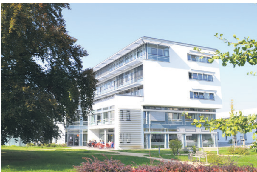
Blick zum Frauen- und Kinderzentrum am Krankenhaus Bautzen
